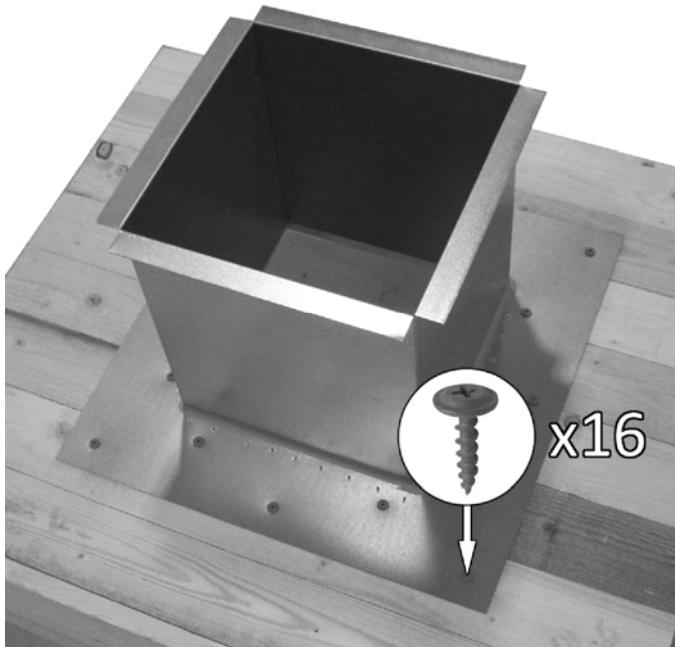
**1.** Tag upp hål 260 x 260 mm i undertak och montera underhuv med bifogad Monteringsskruv (16st). Pappa sedan upp på underbeslagets sidor.
