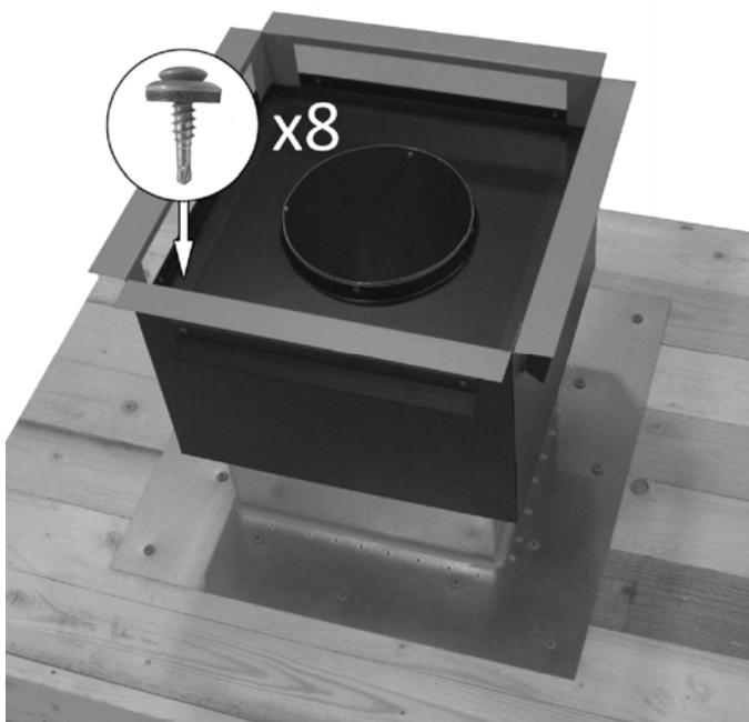
**3.** Montera takhållaren med bifogad Borrandeskruv Torx (8st).
