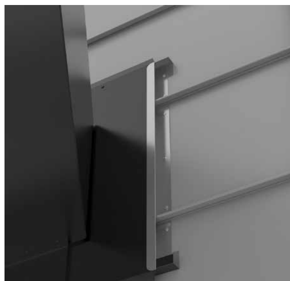
20. Vid behov monteras övergångsplåtar upp tillnock som är 500 mm långa i erforderligt antal. Skjuts upp i varandra. Kantstöd monteras även i varje skarv och längs med sidor upp tillnock. Fäst med LP-skruv.
