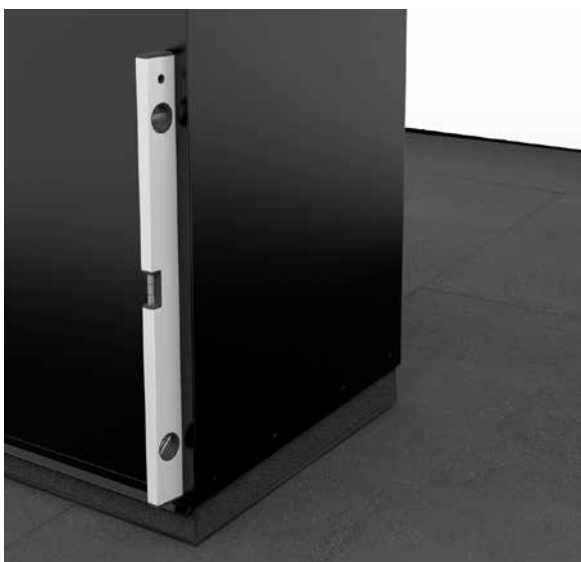
15. Kontrollera med vattenpass att det är lodrätt och skruva fast stosen i sidorna med 8 st LP-skruv 4,8×35.
