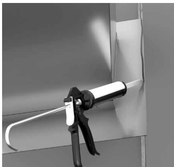
4. Sänk ner stosen i hålet, montera bakstycket av underbeslaget. Skjut upp under tätskikt i bakkant. Applicera tätningsmedel (typ seal & fix) mellan tätskikt och underbeslag.
