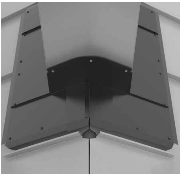
19. Montera de ställbara nockarna med 2 st montageskruv 4,2×25.
