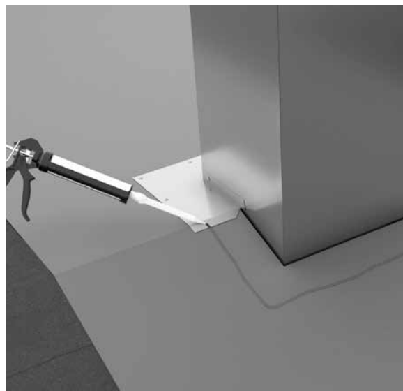
6. Applicera fogmassa på andra sidan och montera nästa del av underbeslaget.
