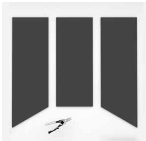
10. Klipp den yttre stosen enligt måttanvisning till rätt taklutning. Här bestämmer du även vilken höjd skorstenen ska ha.
